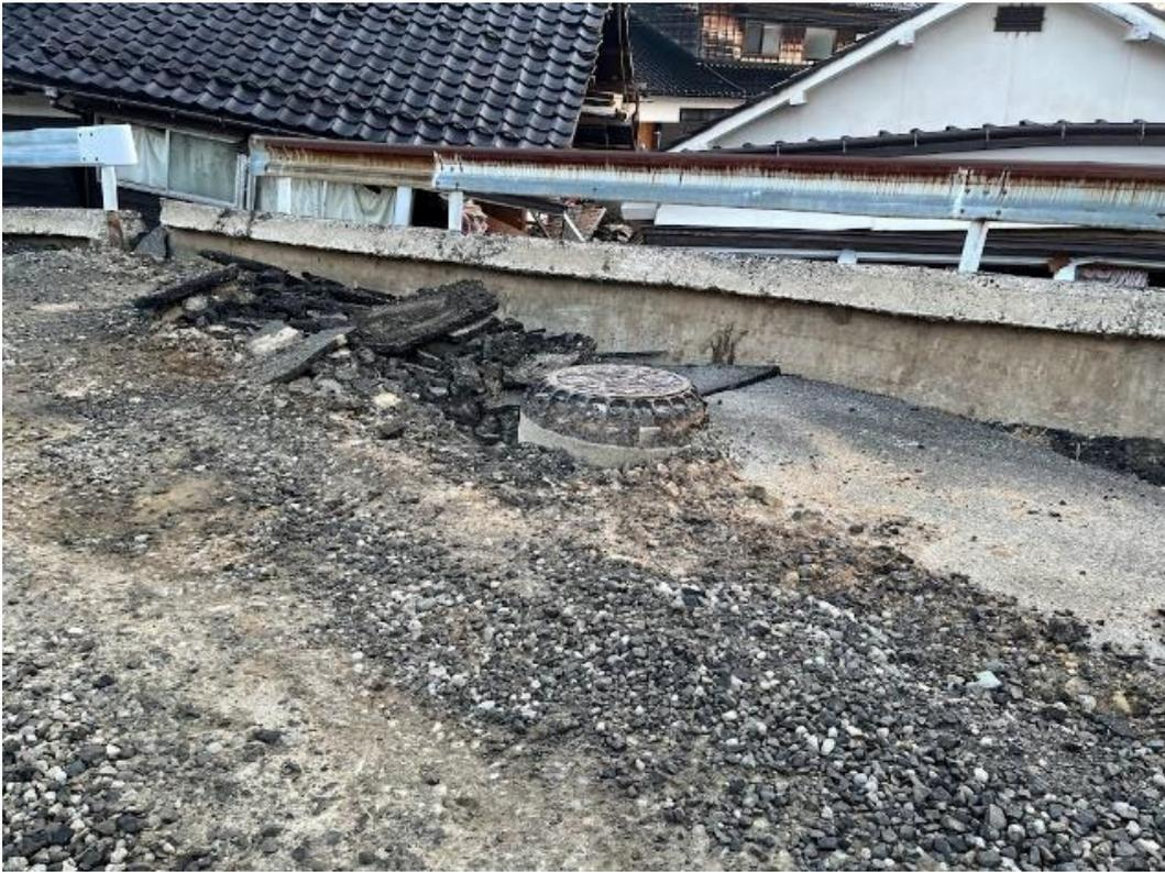
マンホールは高く飛び出している。割れた道路の間に砂利を入れ、通れるよう補修。段差や砂利で歩きにくい。あちこちが隆起して割れた家屋のガラスなども残っており危険。
